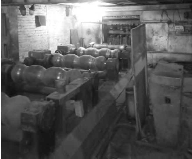
В ЭСПЦ-3 АО «ЗЭМЗ» прошел капитальный ремонт УПНРС №1.
