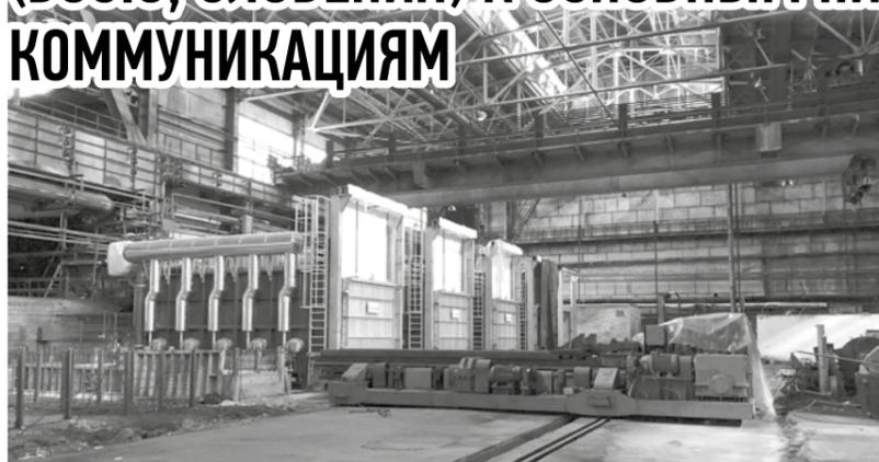
Строительно-монтажные работы на одном из ключевых объектов реконструкции завода вошли в заключительную стадию. В начале июня здесь завершился важный и длительный технологический этап – выполнен монтаж системы газоснабжения, которая обеспечит функционирование всего основного оборудования.
