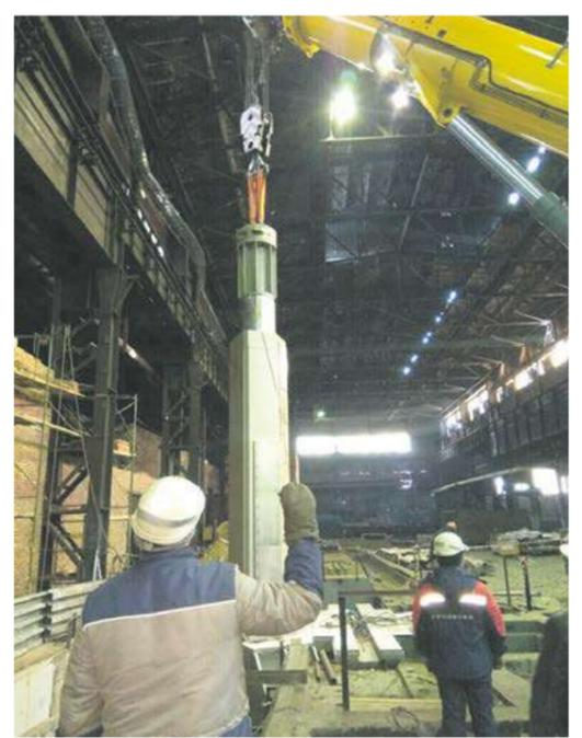
В конце января на предприятии была смонтирована станина корпуса пресса, которая является базовой деталью и будет нести на себе весовую нагрузку всего комплекса в сборе. В первых числах февраля на неё были установлены две колонны пресса, по которым, впоследствии, будет перемещаться подвижная траверса с верхним бойком.
